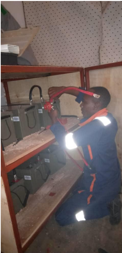
Montage van omvormer, solar controllers, accu's en testen vóór oplevering
