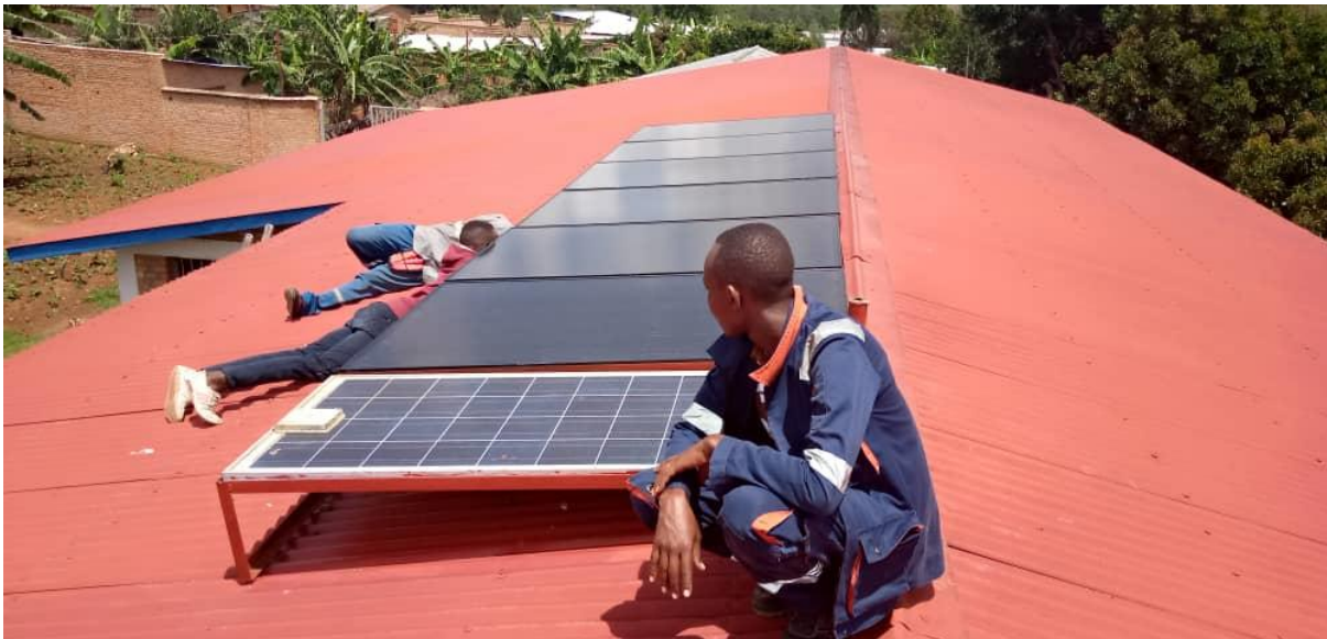
Plaatsing van de frames, de zonnepanelen en bedrading
