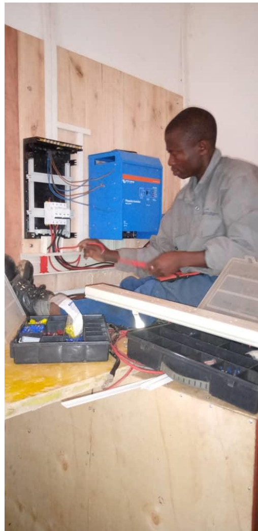
Montage van omvormer, solar controllers, accu's en testen vóór oplevering
