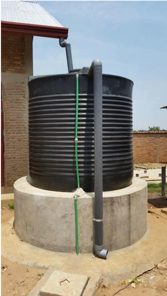
Stichting De Morgenster heeft de aanschaf en bouw van een waterreservoir met een capaciteit van 5000 liter, met opvang van hemelwater, verzorgd.
